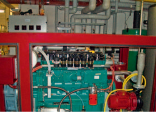
Ein 50-kW-BHKW der Comuna-metall liefert die Grundlast für die Nahwärmeversorgung im Wohnpark Neu-Schladitz
